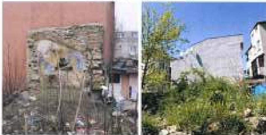
Fotoğraf 55-56: 19 Ada 7. Parsellerde Yer Alan Yapının Önceki ve Sonraki Halli
