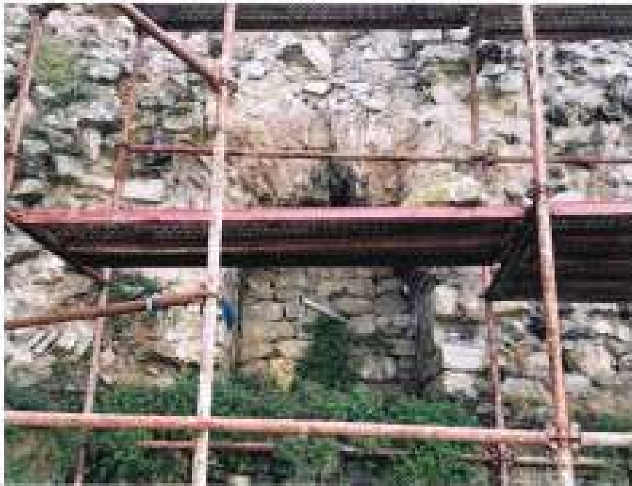
Fotoğraf 2: Tuğla Örgülü Yuvarlak Kemerli Kapı Açıklığı
