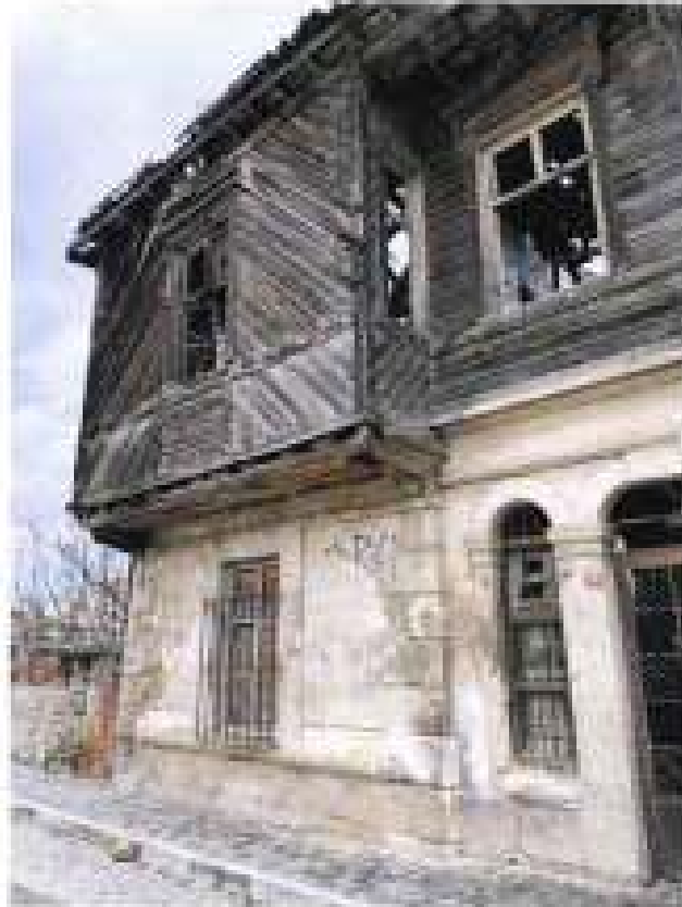
Fotoğraf 26: 38 Ada 8. Parselde Yer Alan Konut
