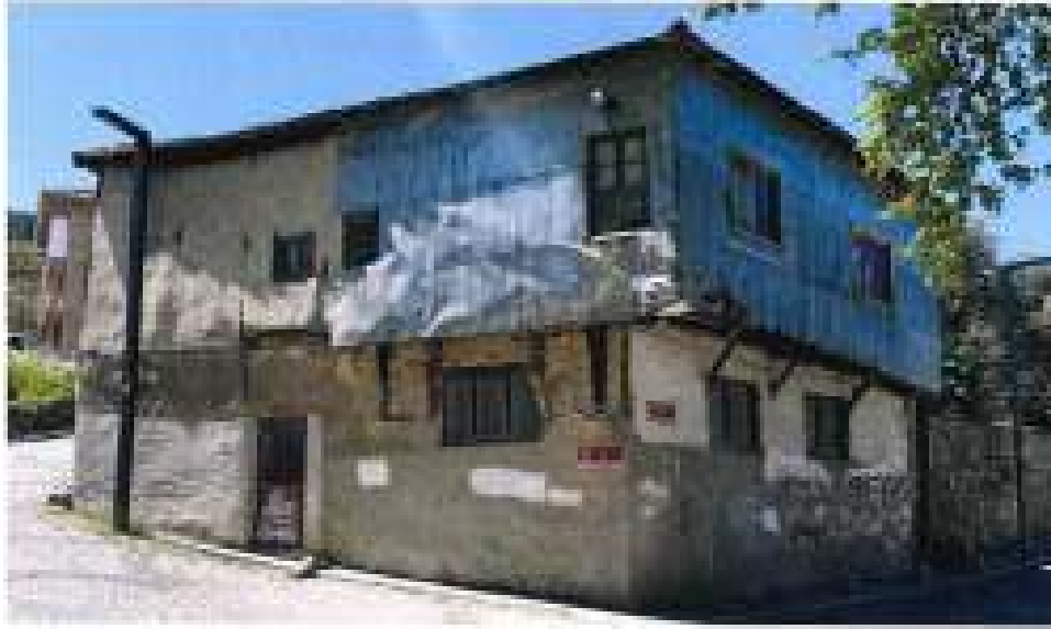
Fotoğraf 8: 12 Ada 5. Parselde Yer Alan Konut
