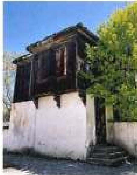
Fotoğraf 15: 28 Ada 1. Parselde Yer Alan Konut
