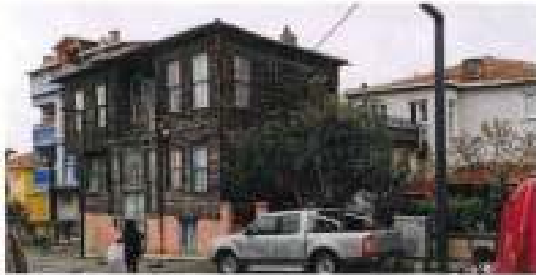
Fotoğraf 8. Avşar Sokak, eski 53 ada 23 parseldeki tescilli yapı
