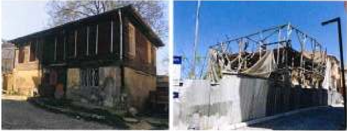
Fotoğraf 23: 32 Ada 8. Parselde Yer Alan Konutun Önceki ve Şimdiki Durumu
