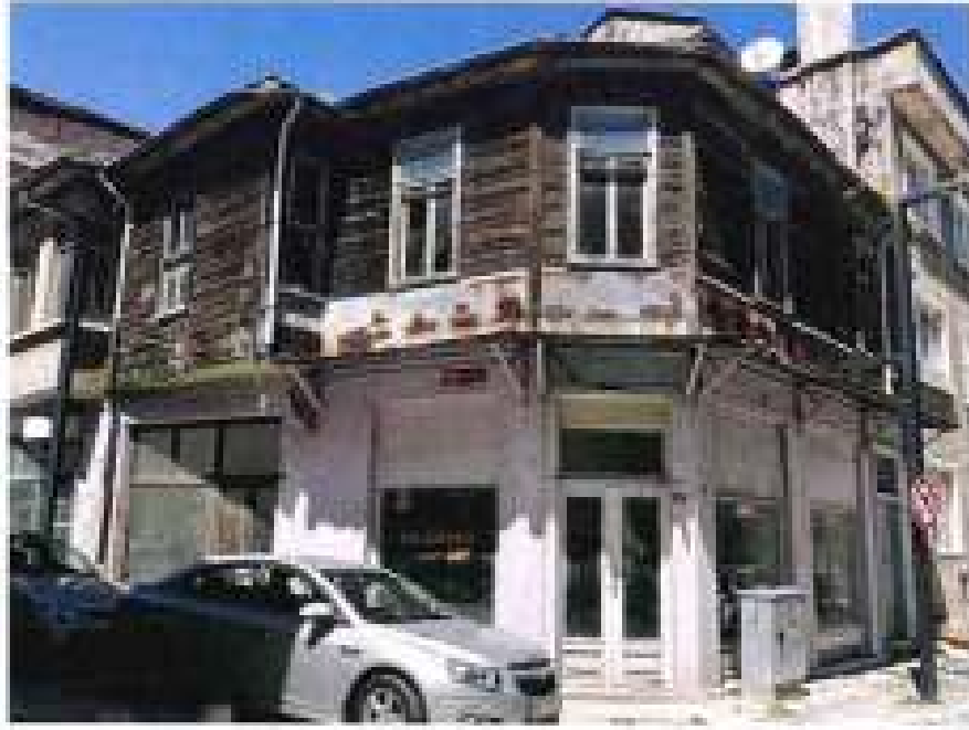
Fotoğraf 38: 53 Ada 4. Parselde Yer Alan Konut
