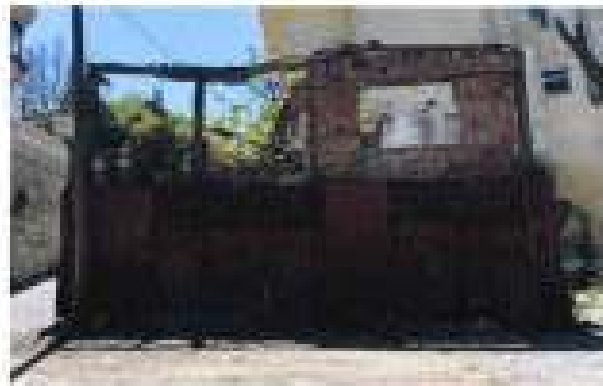
Fotoğraf 9: 17 Ada 1. Parselde Yer Alan Konut
