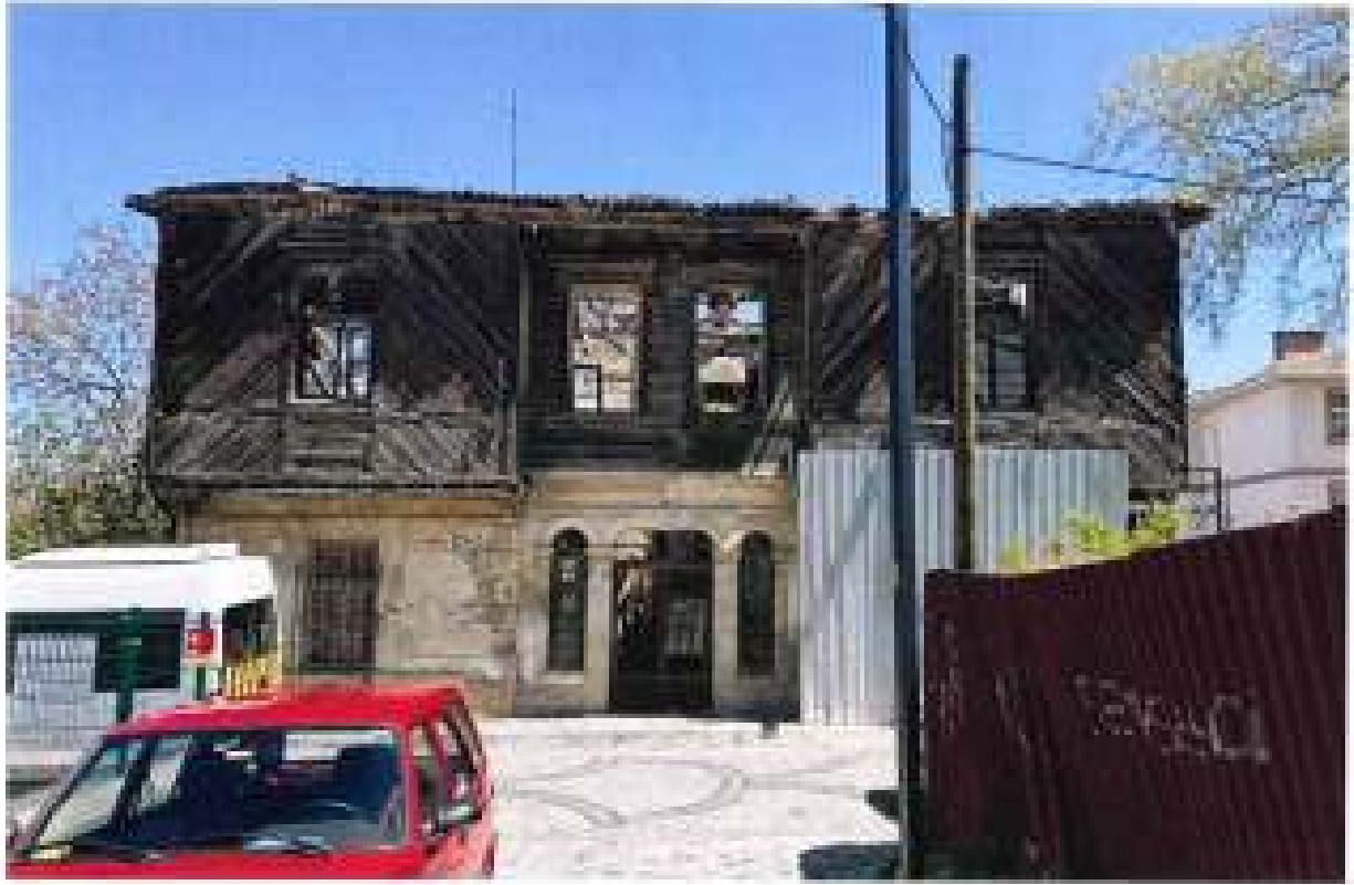
Fotoğraf 25: 38 Ada 8. Parselde Yer Alan Konut
