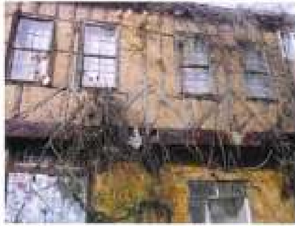
Fotoğraf 48. 2009 Tescil Fişlerinde Ahşap Çatki Arası Kerpîç Dolgu Yapı
