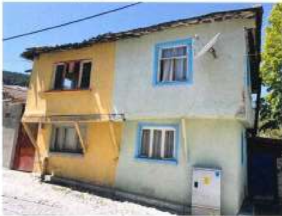
Fotoğraf 22: 31 Ada 12. Parselde Yer Alan Konut
