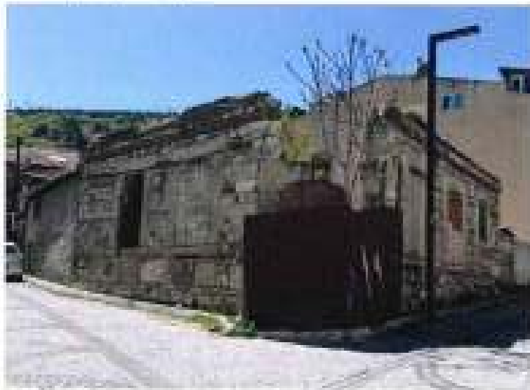
Fotoğraf 42: 56 Ada 5 Parselde Yer Alan Konut
