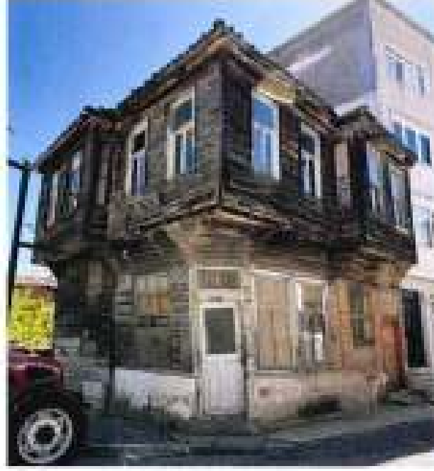
Fotoğraf 31: 46 Ada 9. Parselde Yer Alan Konut
