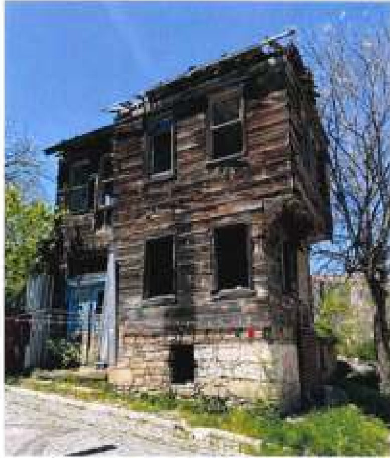
Fotoğraf 10: 19 Ada 3. Parselde Yer Alan Konut
