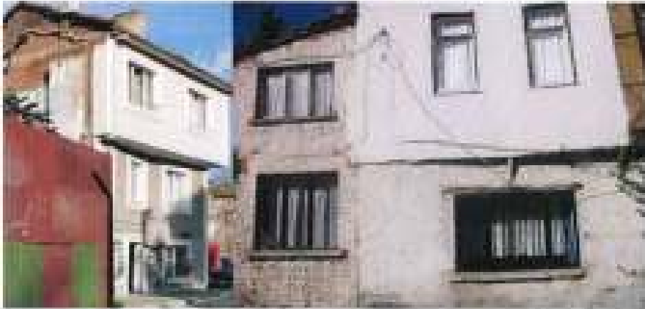
Fotoğraf 42. Bölgede Çeşitli Şekillerde Günümüze Kadar Ulaşmış, Tuğla Örgülü Kargir Yapı Örnekleri
