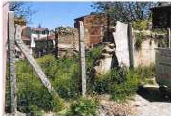
Fotoğraf 17: 29 Ada 2. Parselde Yer Alan Konut
