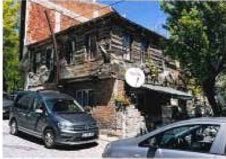
Fotoğraf 27: 42 Ada 12. Parselde Yer Alan Konut
